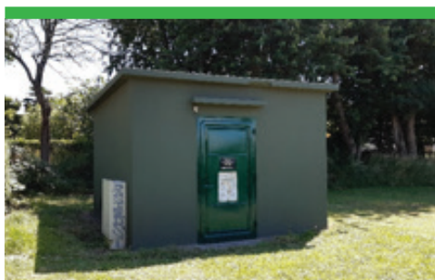
Rénovation d'un poste à Saint-Lô
