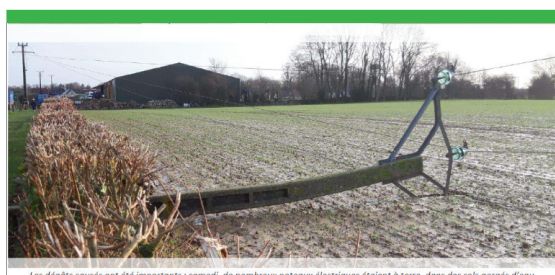
Les dégâts causés ont été importants : samedi, de nombreux poteaux électriques étaient à terre, dans des sols gorgés d'eau.
