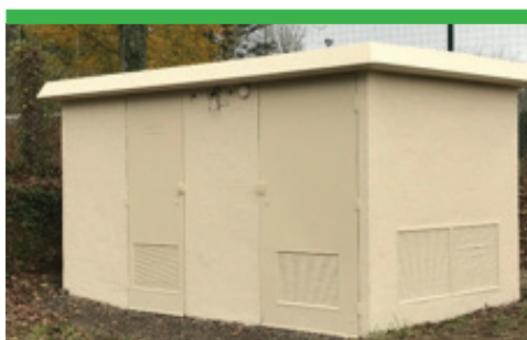
Rénovation d'un poste à Cherbourg en Cotentin
