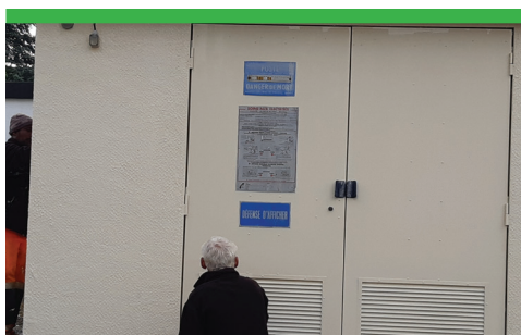
Rénovation d'un poste à Saint-Lô
